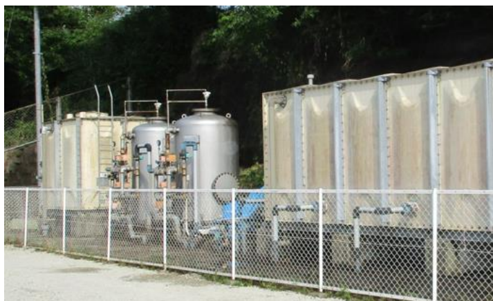
敷地内駐車場にプラント設置
